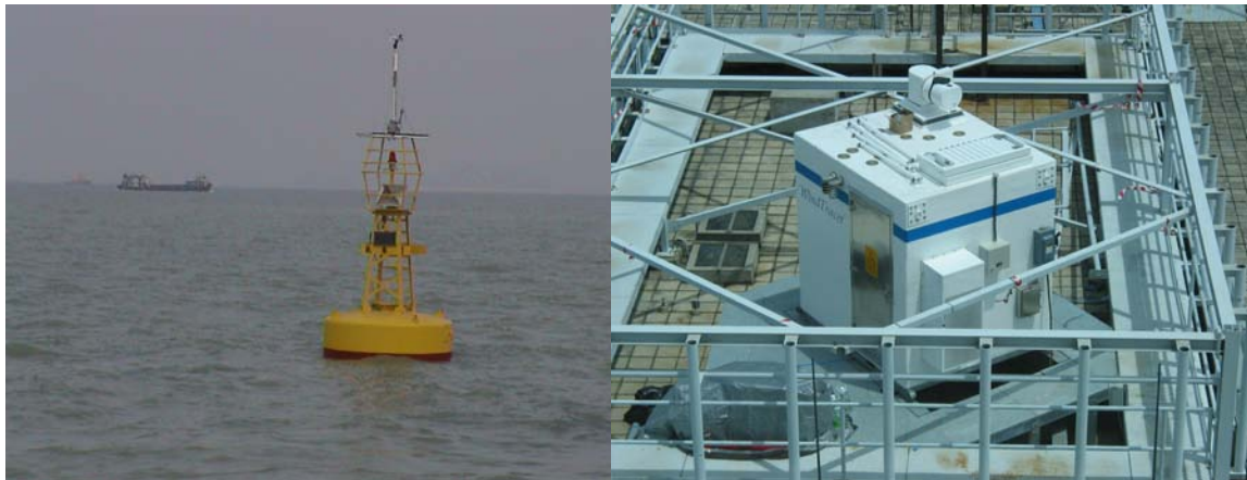
Figura A4-8. Instalaciones de detección de cizalladura del viento establecidas a principios de los años 2000 — boya meteorológica (izquierda) y LIDAR (derecha)
